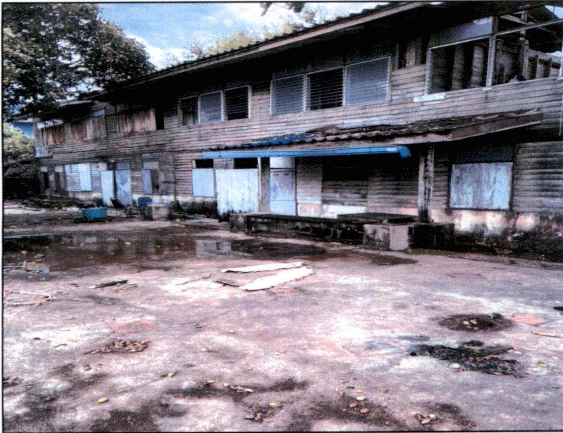
ภาพอาคารบ้านพักเจ้าหน้าที่xonอนุมัติเรือถอน ที่ราชพัสดุแปลงหมายเลขที่ สข.๔๘ เป็นหลังลำดับที่ ๖
